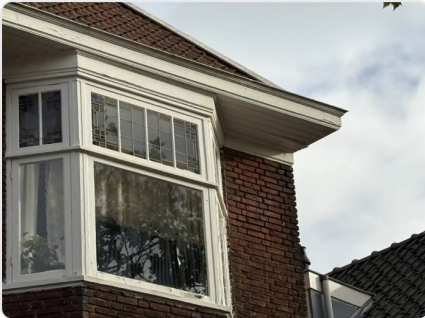
Erkerkozijn voorgevel, verdieping 1
