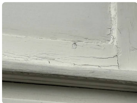
Foto 2 · hoekverbinding kozijn
