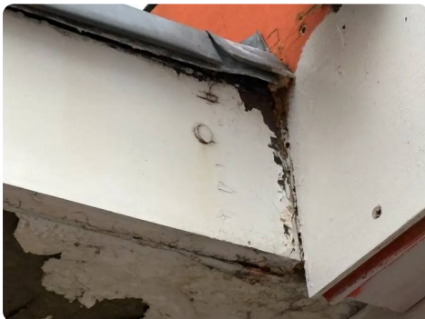
Foto 5 · betonluifel bij regenpijp
