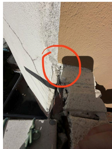
Situatie gevel: aansluiting van het balkon op de gevel, met infiltratiepunten waardoor capillaire vochtdoorslag mogelijk is.
